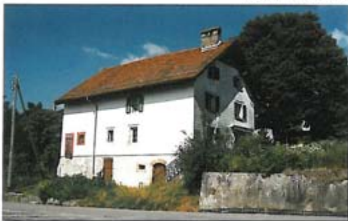
Vue avant - transformation
