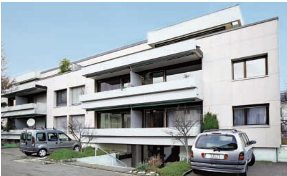
Dans l'immeuble de dix logements à Reinach BL, un CCF d'une conception nouvelle produit de la chaleur et de l'électricité
