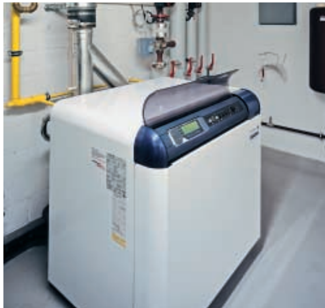
Peu encombrante, la chaudière modulante à condensation à gaz de 80 kW
