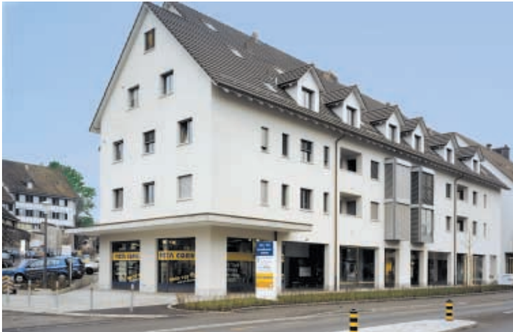
Le nouveau bâtiment pour douze familles et pour des locaux artisanaux à Bülach
