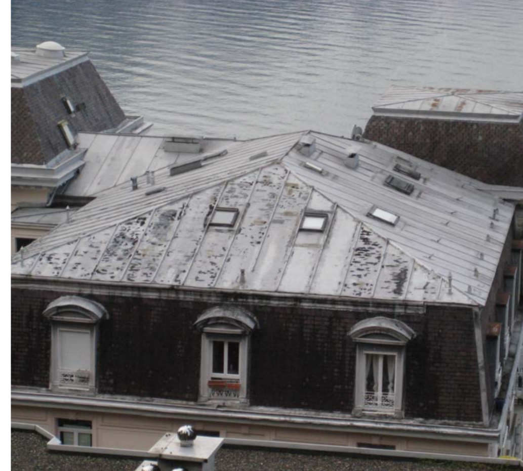
Avant travaux: toiture
