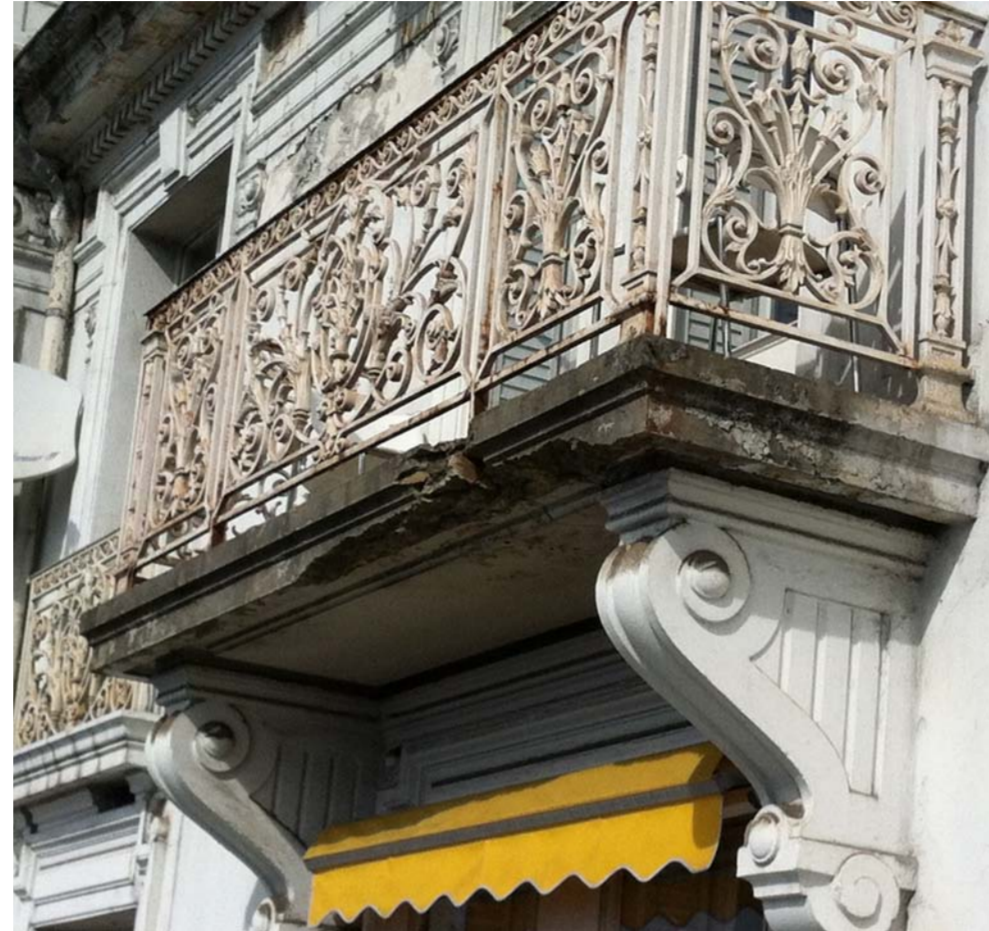
Avant travaux: balcon
