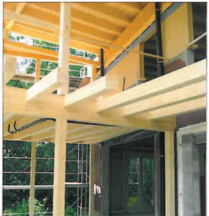
La structure en sapin s'adosse à l'existant, dont les parois sont ventilées avec 20 cm de roche de laine et dont la toiture est refaite.
