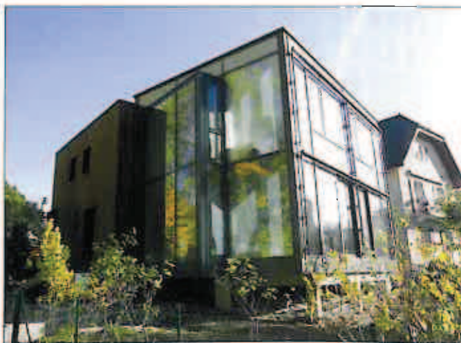
Cette récente réalisation révèle un nouveau volume qui offre aux habitants 97 m 2 supplémentaires habitable (habitation) et non habitable (serre).
